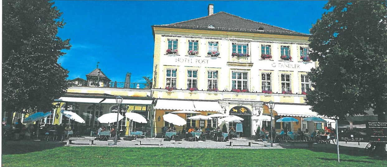
Das Sanierungskonzept für das Hotel Zur Post sieht vor, dass im Oktober 2020 wiedereröffnet wird. – F.: Schwarz
